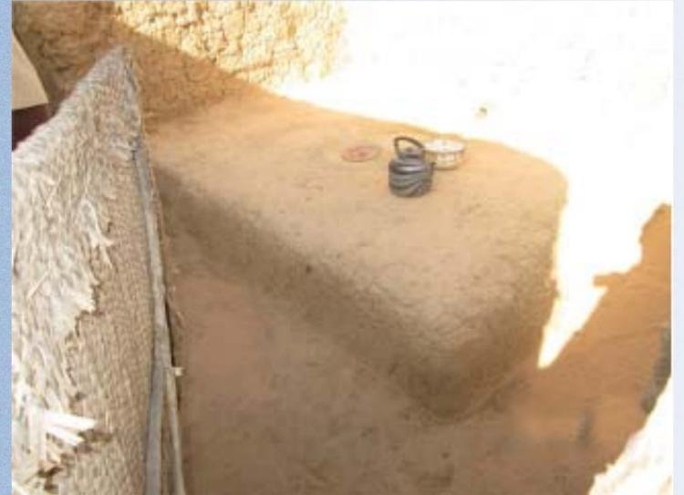
Le trou de la latrine dans une zone inondée, n'est pas profond (Max 0,65 m). Le reste est récupéré par une élévation autour du trou
