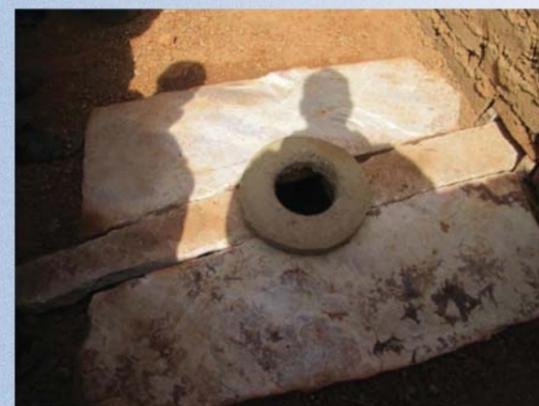
Pose de la fermeture pour bien mettre en forme le trou de la défécation
